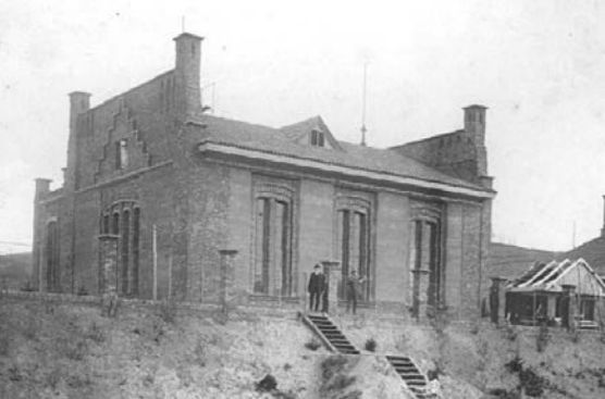
← Vršovická vodárna, Praha / Het waterpompgebouw in Vršovice, Praag
